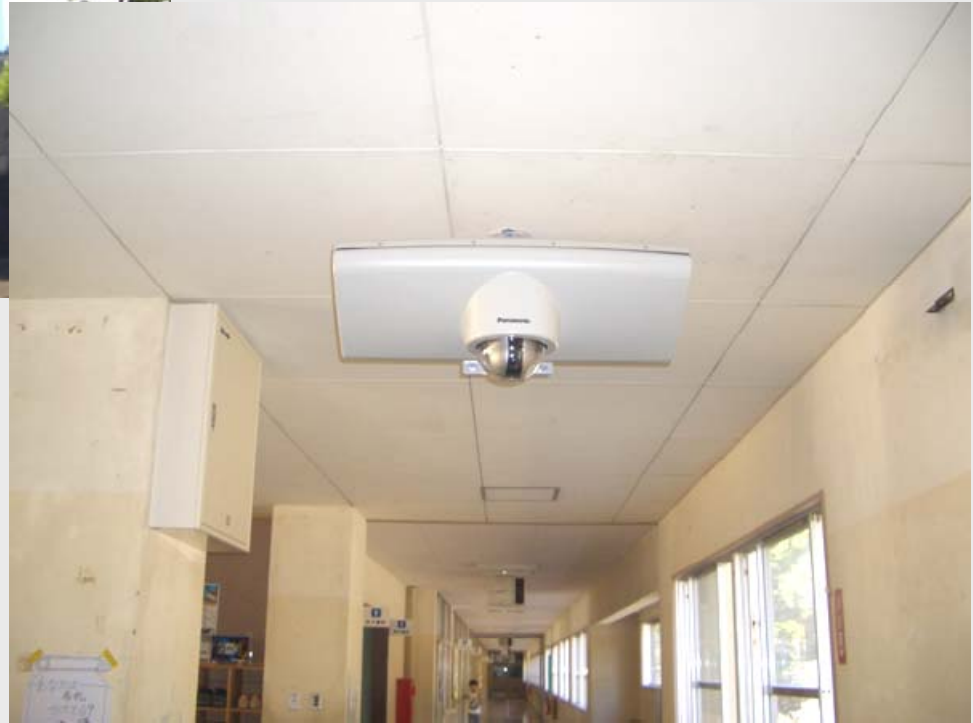
下駄箱へのリーダー設置状況
